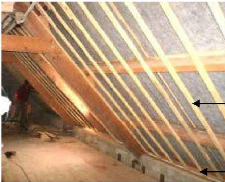
**Fixation du calage**, constitué de chevrons pour la mise en place du parement intérieur et qui donnera l'épaisseur de l'isolation
