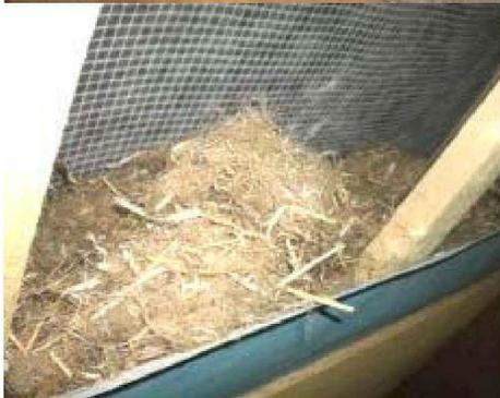
La fibre de **chanvre** doit être posée à une densité de **60 kg/m3**.
