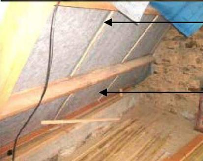
Le but : assurer une bonne étanchéité à l'air et empêcher les mouvements d'air dans l'isolant. Idem concernant le retour sur les murs et les recouvrements des lés
